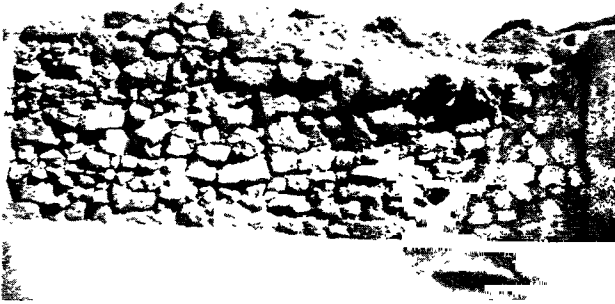
Fig. 75. Vouni. The palace. Wall 183.
